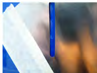
2. Positionner le pochoir sur le défaut et le maintenir à l'aide de bande cache.
